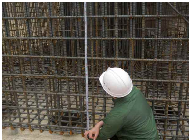
P1 기초측면 수평철근 간격측정
