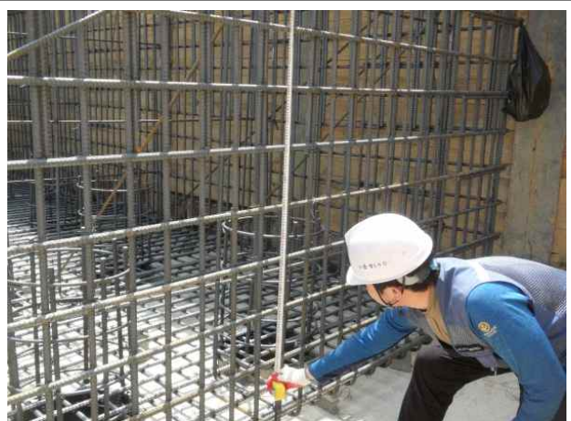
P2 기초측면 수평철근 간격측정
