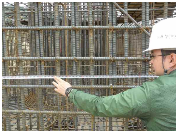
P1 기초측면 수직철근 간격측정
