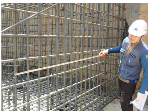
P2 기초측면 수직철근 간격측정
